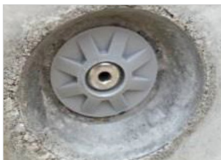
HyDra RiveStop PS efter installation
